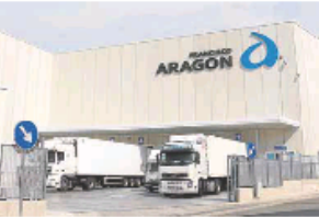
Exterior de una de las instalaciones de Francisco Aragón
